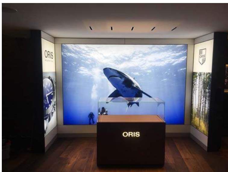
Leuchtkästen, flächenbündig in Wandanlage eingepasst
