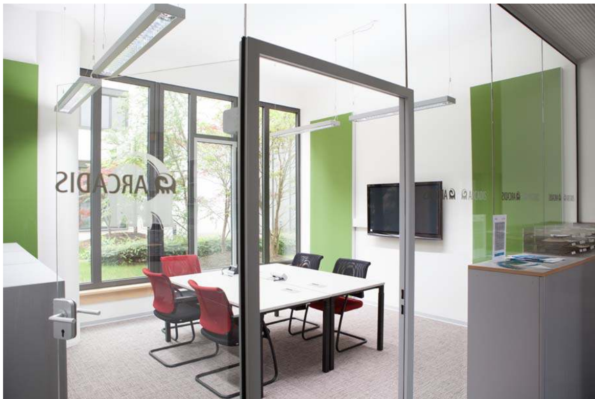
| Akustik-Textilspannrahmen, einseitig für ein Sitzungszimmer
